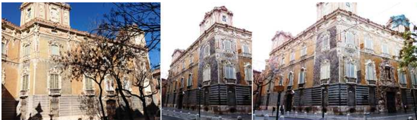
❶ Fachada en la calle Poeta Querol. ❷ En cada ángulo posee un pequeño torreón rectangular. ❸ A la derecha su entrada por la calle Cámara.
