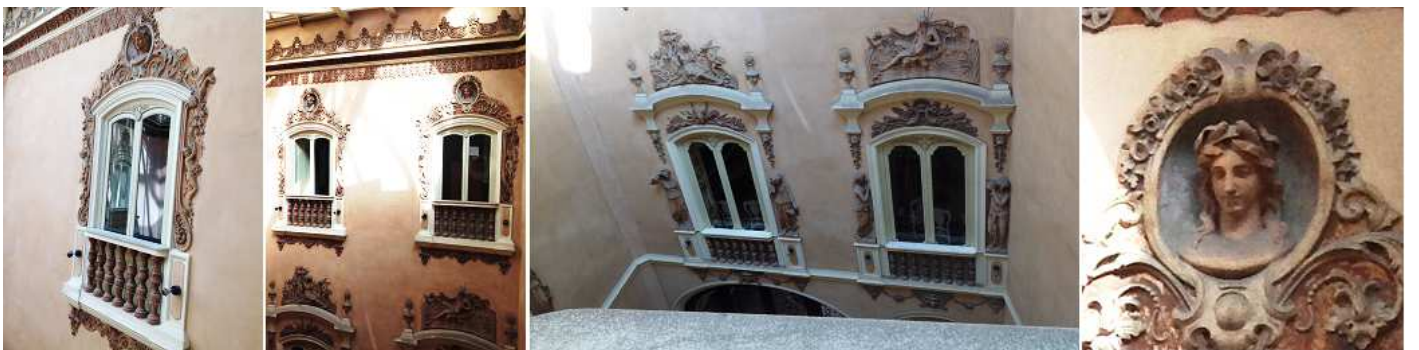
1 Cruzamos por el pasillo que da al patio para seguir la visita de las siguientes salas, y podemos observar las ventanas de esta segunda planta. 2 Con decoración vegetal y figuras a sus lados. 3 Ventanas de la primera planta. 4 Plafón sobre las ventanas.
